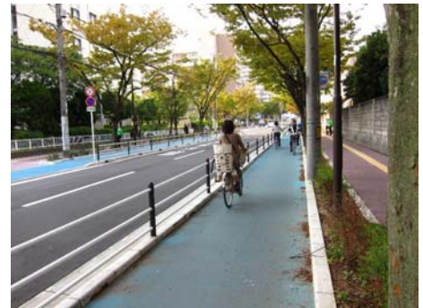
(写真) 新金岡 80 号線自転車道
